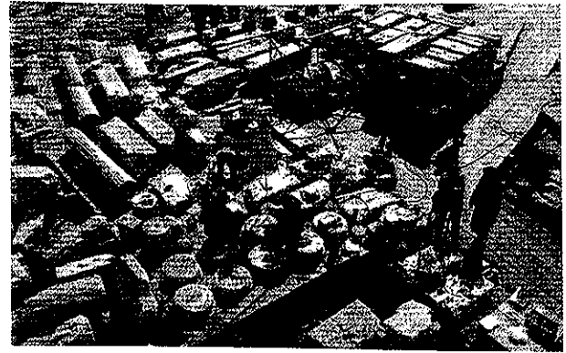
Fig. 4 (nella colonna di sinistra) - Il sistema costruttivo articolato a secco nel muro sud dell'edificio centrale dei Propilei.
