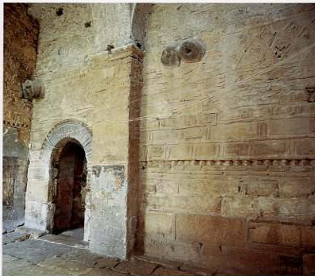
Εικ. 161. Παρηγορήτισσα. Νότιος τοίχος του βόρειου παρεκκλησίου (διακρίνεται η τοιχοποιία του αρχικού ναού).
