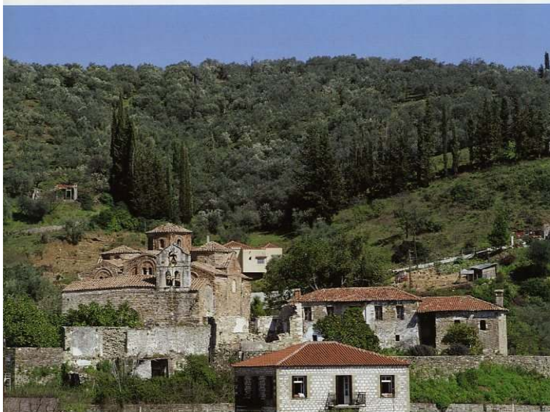
Εικ. 97. Βλαχέρνα. Άποψη του βυζαντινού ναού και των προσκτισμάτων.
