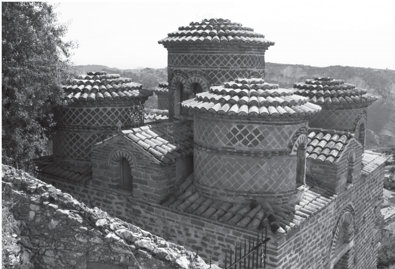
Fig. 2. Stilo, Cattolica. Particolare delle cupole
