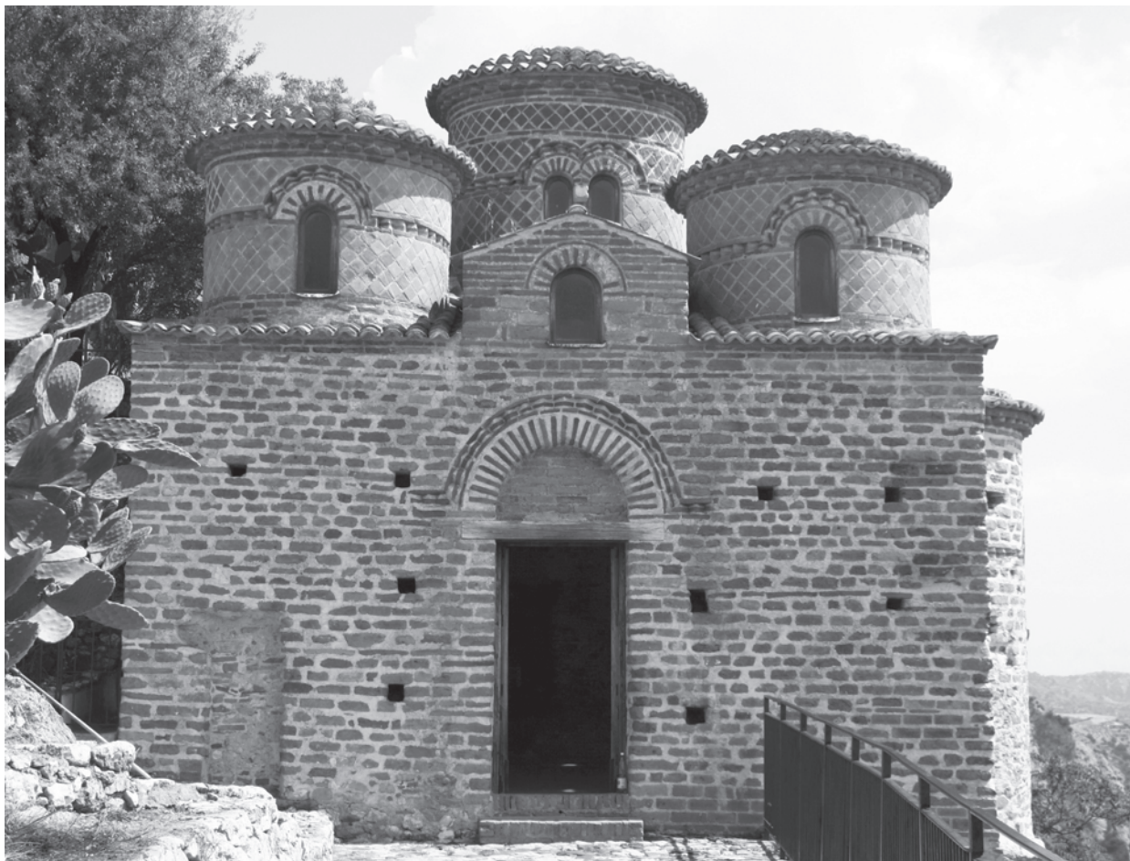
Fig. 1. Stilo, Cattolica. Fronte principale della chiesa
