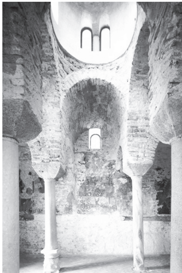
Fig. 5. Stilo, Cattolica. Interno, parete ovest
