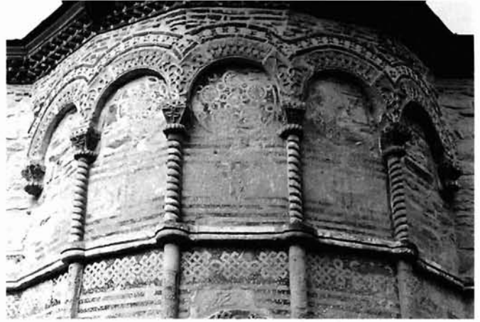
18. Αναπαράσταση συστήματος δόμησης πάνω σε εξωτερική τοιχοποιία σε συνδυασμό με διακοσμητικά θέματα. Μονή Ljubostinja (1386), Σερβία.
