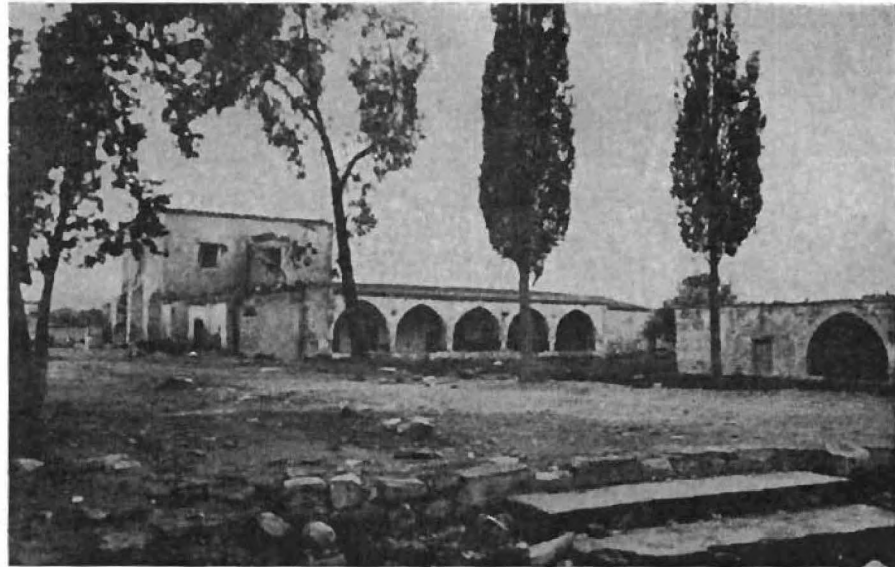
Γενική άποψη των Μοναστικῶν οίκημάτων τῆς Μονῆς Ἁγ. Σπυρίδωνος ἀπὸ β.α.
