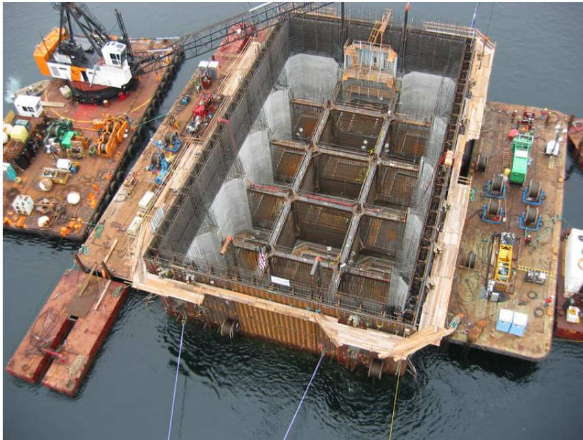
Σχ. 6: Φωτογραφία κάτοψης πλωτών κιβωτίων (caissons)
