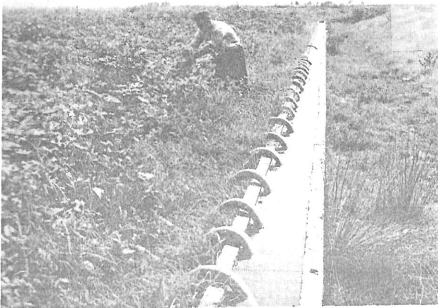
Σχήμα 2: Σιφώνια που διοχετεύουν το νερό μέσω της αρδευτικής διώρυγας στο χωράφι.
