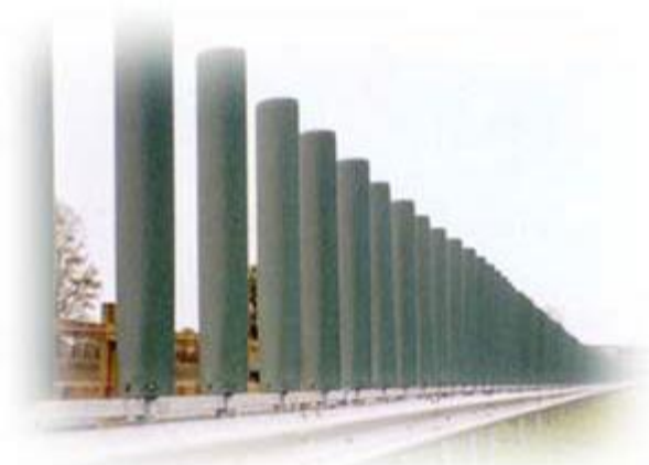
Αντιθαμβωτικό πέτασμα από κατακόρυφους στύλους
