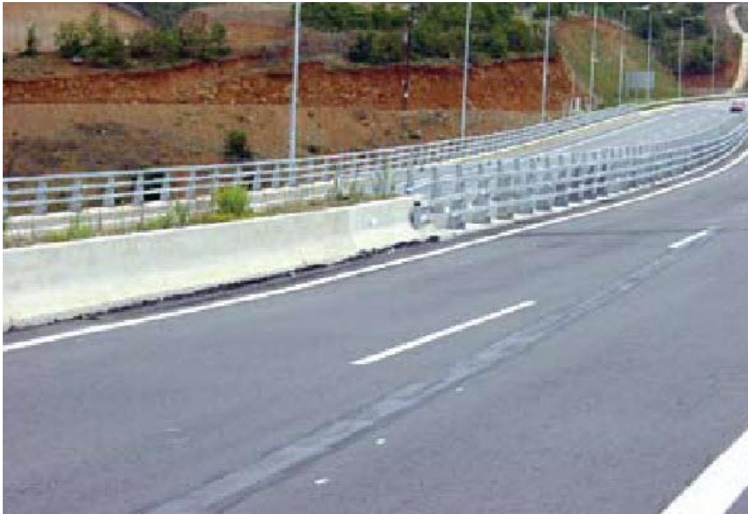
Συναρμογή στηθαίων σκυροδέματος με διατομή New Jersey και μεταλλικού στηθαίου γέφυρας σε ελληνικό αυτοκινητόδρομο
