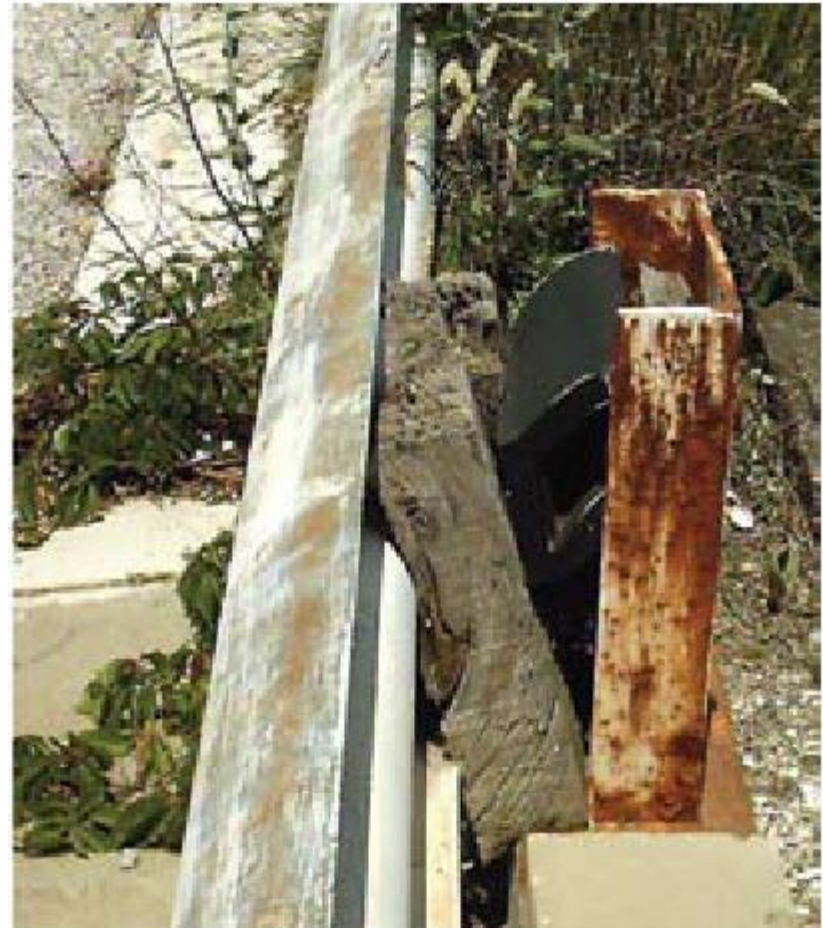
στηθαία με πλάκα έδρασης σε τεχνικό έργο και παρεμβλήματα από ξύλο και ελαστικό
