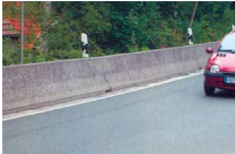
Πρώτη εφαρμογή στηθαίων από σκυρόδεμα με διατομή New Jersey στη Γερμανία (έτος κατασκευής 1980)
