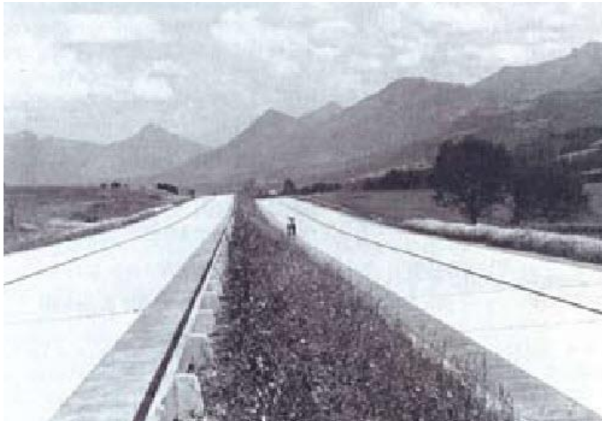
Ξύλινα στηθαία ασφαλείας με πασσάλους από οπλισμένο σκυρόδεμα στον αυτοκινητόδρομο Μονάχου παρά το Irschenberg
