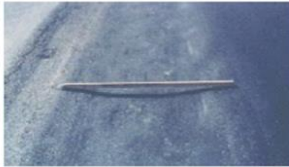
Φωτογραφία 11. Αιλακώσεις στις τροχιές των τροχών
