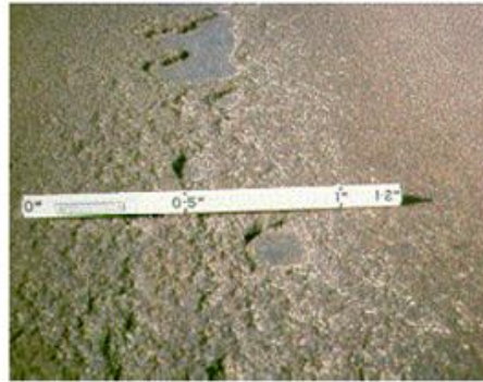
Φωτογραφία 16. Αποκόλληση κατά πλάκες
