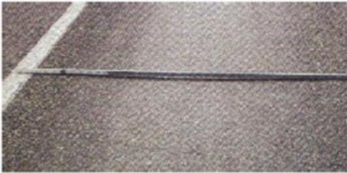
Φωτογραφία 11. Αιλακώσεις στις τροχιές των τροχών
