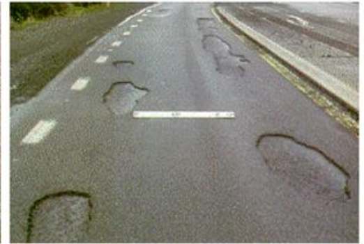
Φωτογραφία 16. Αποκόλληση κατά πλάκες
