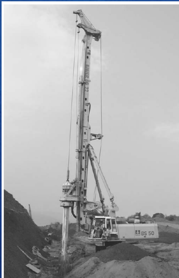
Εγχυτοι πάσσαλοι (φρεατοπάσσαλοι)
