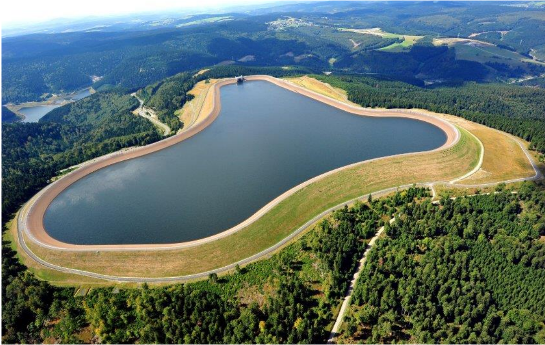
Σχήμα 14.1. Φωτογραφία τους ανώτερου ταμιευτήρα του σταθμού αντλησιοταμίευσης στο Goldisthal της Γερμανίας που βρίσκεται σε υψόμετρο 880 m. Κατασκευάστηκε μεταξύ 1997 και 2004 και έχει ισχύ 1060 MW (χρησιμοποιούνται τέσσερις υδροστρόβιλοι Francis).
