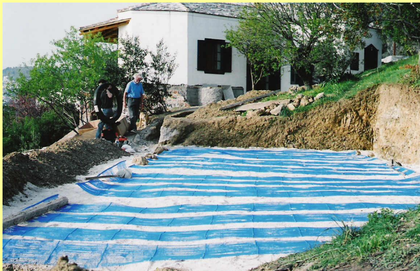
Εγκατάσταση σωληνώσεων σε οριζόντιο σύστημα ΓΑΘ
