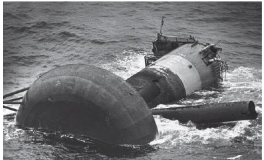
Σχήμα 3: (α) Η πλατφόρμα Alexander Kieland, (β) ένα από τα υποστυλώματα επιπλέει μετά την κατάρρευση της πλατφόρμας τον Μάρτιο του 1980
