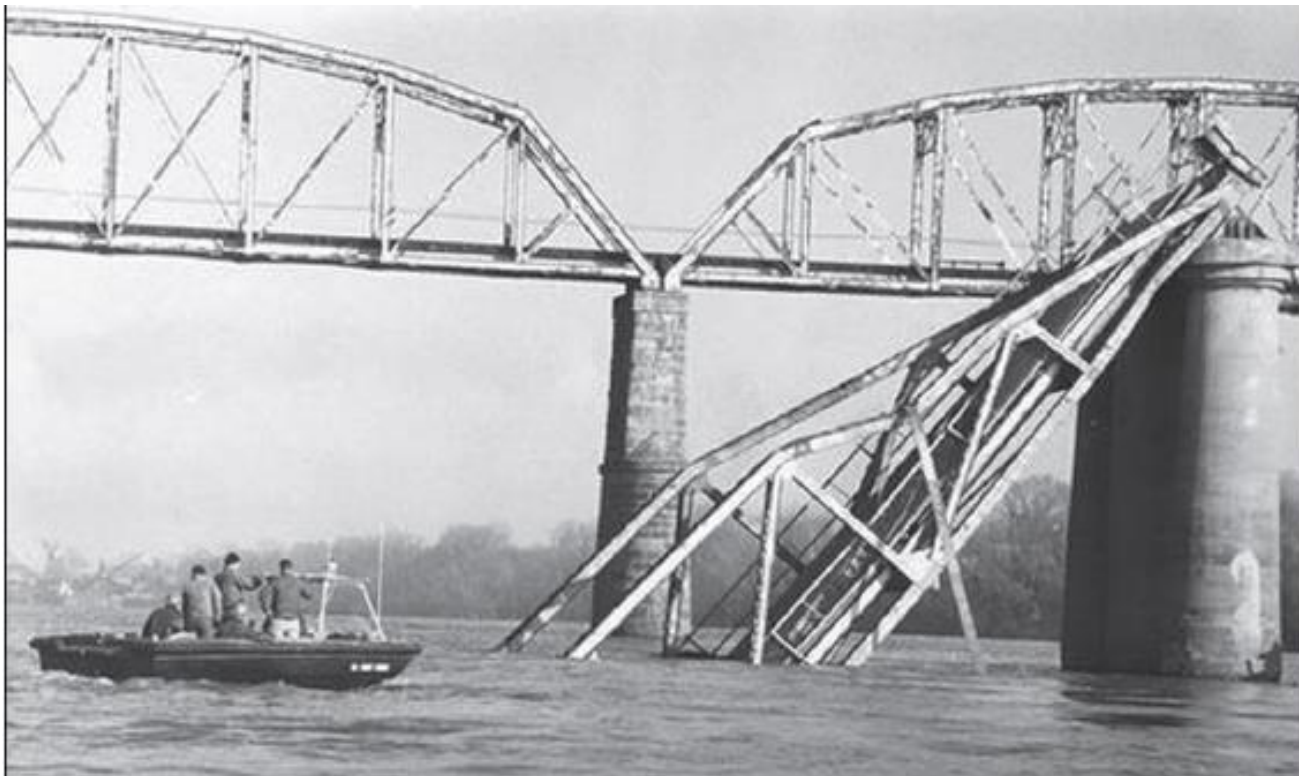
Σχήμα 2: Η γέφυρα Point Pleasant στην δυτική Βιρτζίνια (ΗΠΑ) μετά την κατάρρευση της τον Δεκέμβριο του 1967
