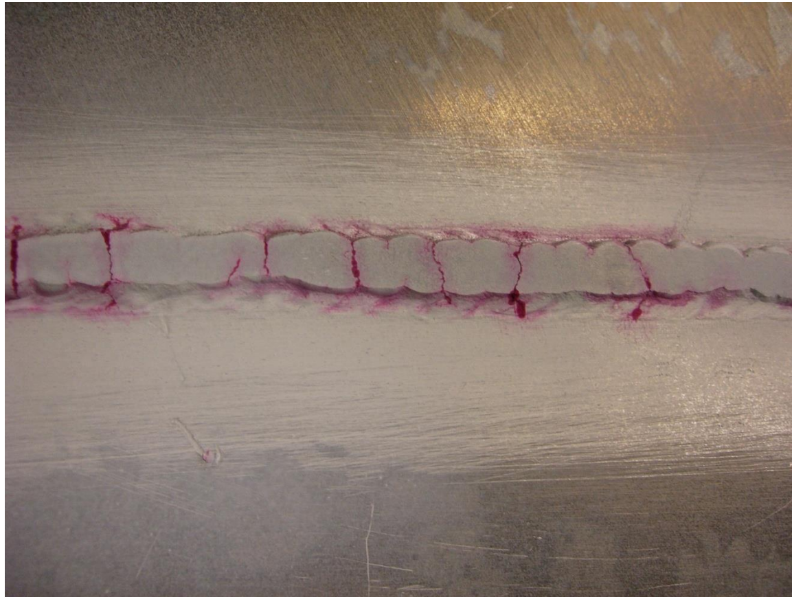
Σχήμα 13: Ανίχνευση ρωγμών με διεισδυτικά υγρά
