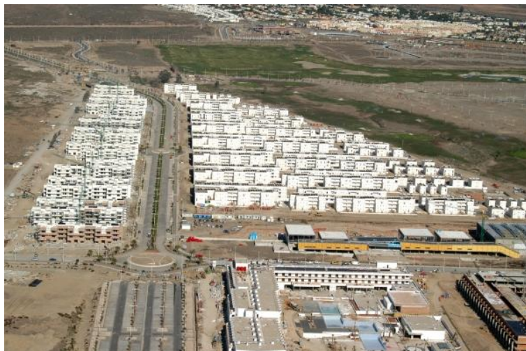
Εικόνα 1. Το Μεσογειακό Χωριό υπό ανέγερση
