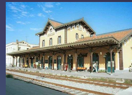
Σιδηροδρομικός Σταθμός Βόλου
