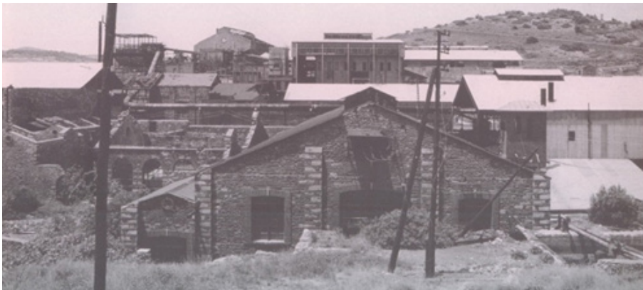
Κτίριο του Ηλεκτρικού Σταθμού Πηγή: Τεχνολογικό - Πολιτιστικό πάρκο Λαυρίου - Πανεπιστημιακές εκδόσεις Ε.Μ.Π
