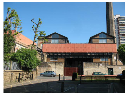
Μετατροπή υδραυλικού αντλιοστασίου σε εκθεσιακό χώρο (κατά τη διάρκεια και μετά την αποκατάσταση)
