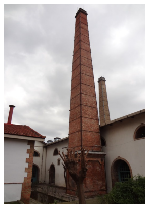
Κτίριο ρύθμισης της πίεσης Κτίστηκε γύρω στο 1864. Ήταν ο τελευταίος σταθμός του φωταερίου στη γραμμή παραγωγής του εργοστασίου. Από εδώ ξεκινούσε Στο εσωτερικό του διατίθενται μηχανήματα ρύθμισης ενώ κάτω από τα γυάλινα θύρακινα οι υπόγειες σωληνώσεις
