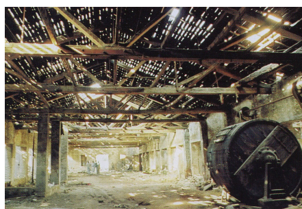
(Αριστερά) Κατάσταση του κτιρίου πριν από την έναρξη εργασιών επισκευής και αποκατάστασής του Πηγή: Αποκατ. Μνημείων Αναβίωση Ιστορικών κτιρίων στην Αττική, β' τόμος
