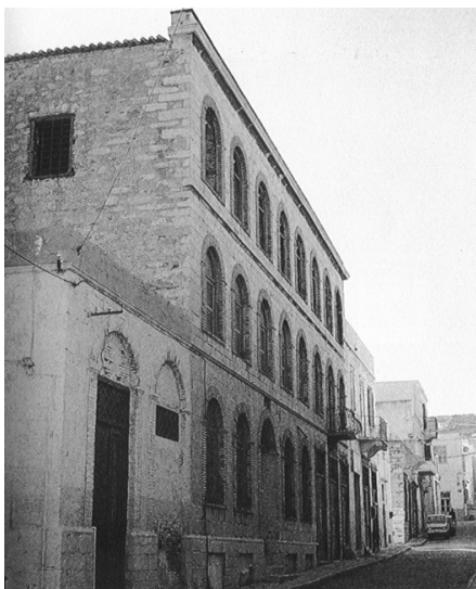
Εργοστάσιο στην οδό Φολέγανδρου στην Ερμούπολη Σύρου Πηγή: Ι. Κατσιγιάννη, Α. Κονδύλη – Λάγαρη, 2000
