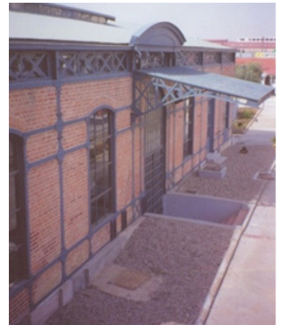
Μουσείο Ύδρευσης Θεσσαλονίκης Κεντρικό κτίριο μηχανημάτων μετά τις εργασίες αποκατάστασης Πηγή: Αποκατάσταση Μνημείων Αναβίωση Ιστορικών κτιρίων στη Βόρεια Ελλάδα, β' τόμος
