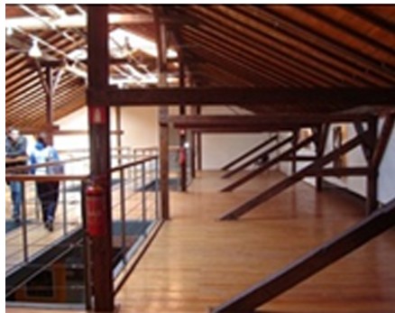
Επίσκεψη στο κτίριο Σπήρερ (προσωπικό αρχείο 2010)
