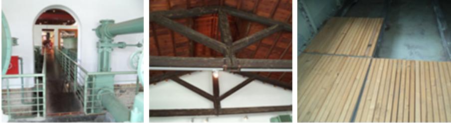
Δεξαμενές καθαρισμού, Πηγή: προσωπικό αρχείο
