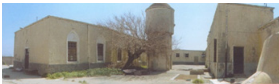
Συγκρότημα Δημοτικών Σφαγείων στη Ρόδο Πηγή: Η Βιομηχανική Κληρονομιά της Δωδεκανήσου, 2009
