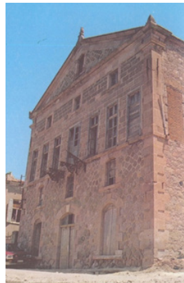
Σαπωνοποιία Πλωμάρι Πηγή: "Τα βιομηχανικά κτίρια της Λέσβου", Ν.Σηφουνάκης
