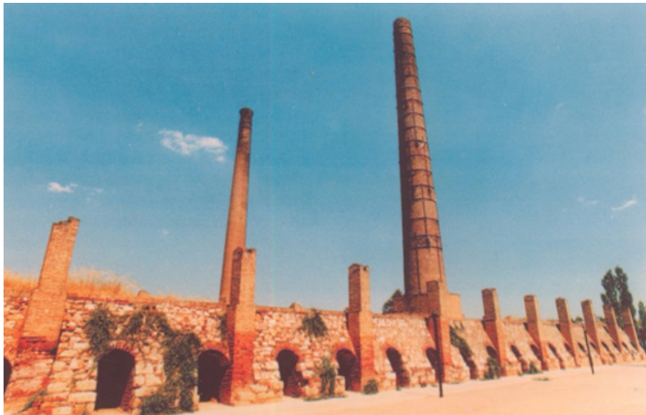
Βόρεια όψη της καμίνου Δηλαβέρη (19ος και αρχές 20ου αιώνα) Πηγή: Ιστορικός Βιομηχανικός εξοπλισμός στην Ελλάδα, Εθνικό Μετσόβιο Πολυτεχνείο, Εθνικό ίδρυμα ερευνών, Υπουργείο Ανάπτυξης, Πανεπιστημιακές εκδόσεις ΕΜΠ, εκδόσεις Οδυσσέας.
