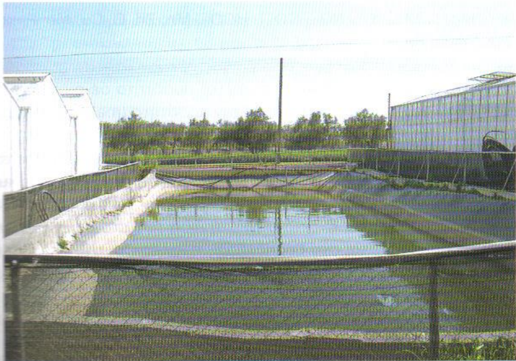
Εικόνα 6: Δεξαμενή αποθήκευσης βρόχινου νερού
