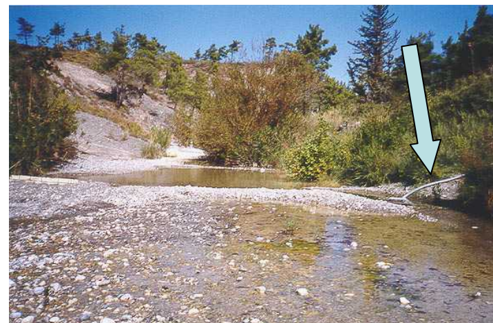
Μικρό ανάχωμα κατασκευασμένο για άρδευση, στην κοίτη του Γαδουρά
