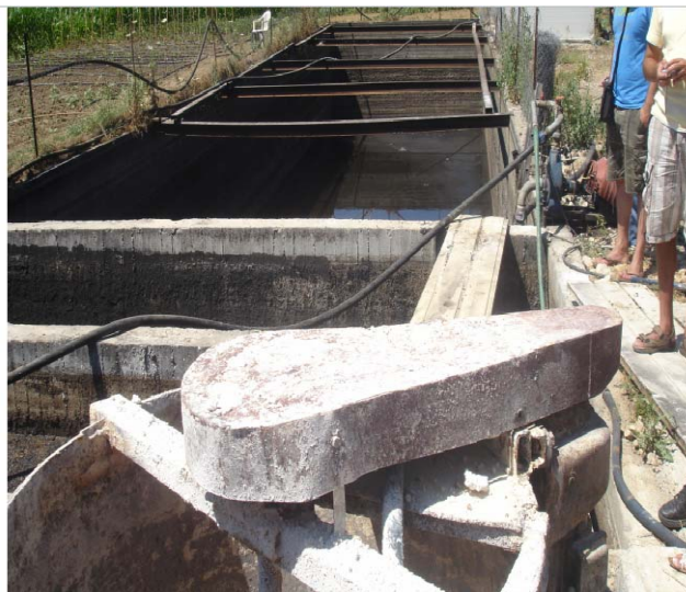
Εικόνα 5: Δεξαμενή καθίζησης με ασβέστωση \text{CaO} .
