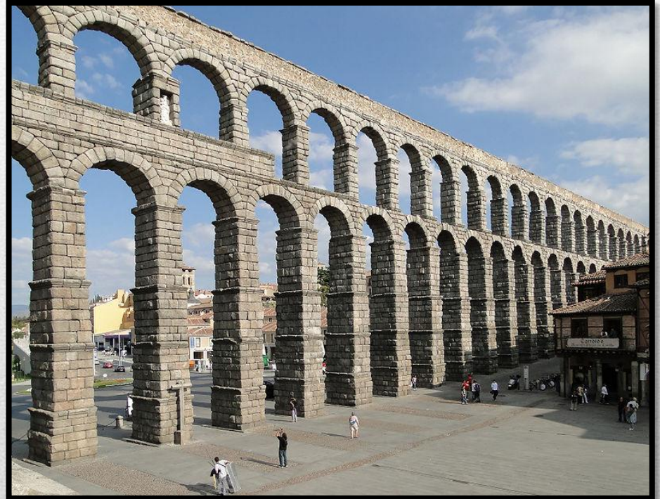
41) Υδραγωγείο Segovia, Ισπανία
