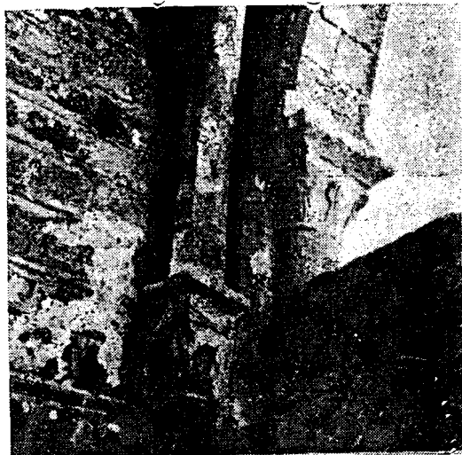
Εἰκ. 16. Τὸ φουρούσι καὶ τὸ «βεργί» τοῦ Δ σταυροθολίου τοῦ ἱεροῦ βήματος τῆς Ἁγίας Σοφίας στὴν Ἀνδραβίδα. Διακρίνεται τὸ κολονάκι μὲ τὸ «κιονόκρανο» ποὺ στηρίζει τὸ ὀξυκόρυφο μετωπικὸ τόξο τοῦ ἱεροῦ.
