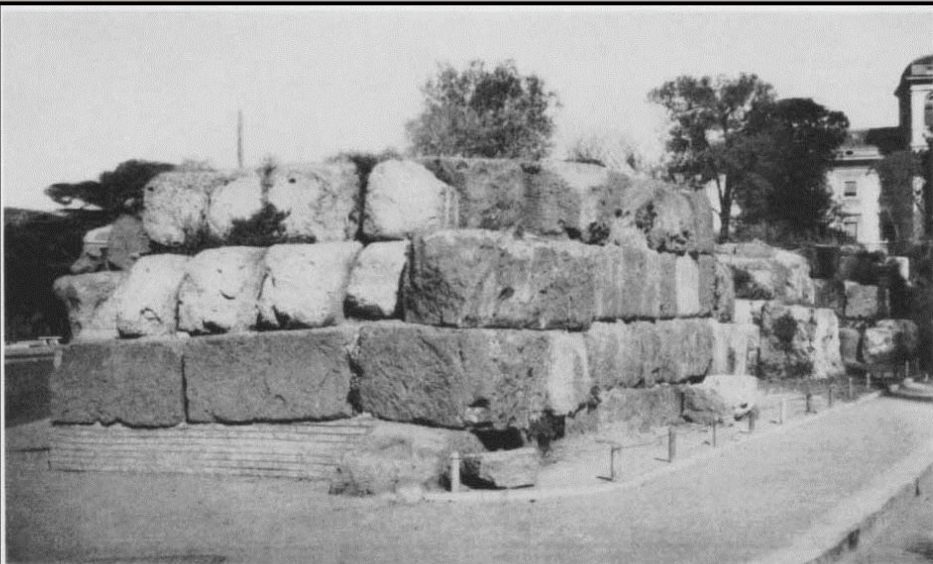
810 The wall in the Piazza dei Cinquecento, north-west of the Porta Viminalis (q. v.).
