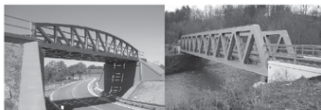
Εικόνες 3 και 4: Παραδείγματα γεφυρών. Πηγή: Railway bridges. Top Con Service [online]. 1992-2011 [cited. 02.19.2012]. Διαθέσιμη από την ιστοσελίδα: http://www.topcon.cz/reference/railway-mosty.htm
