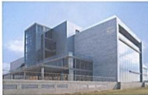
Όψη από τη Σάλαβα / Βορειοδυτική όψη
