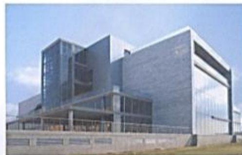
Όψη από τη Σάλαβα / Βορειοδυτική όψη
