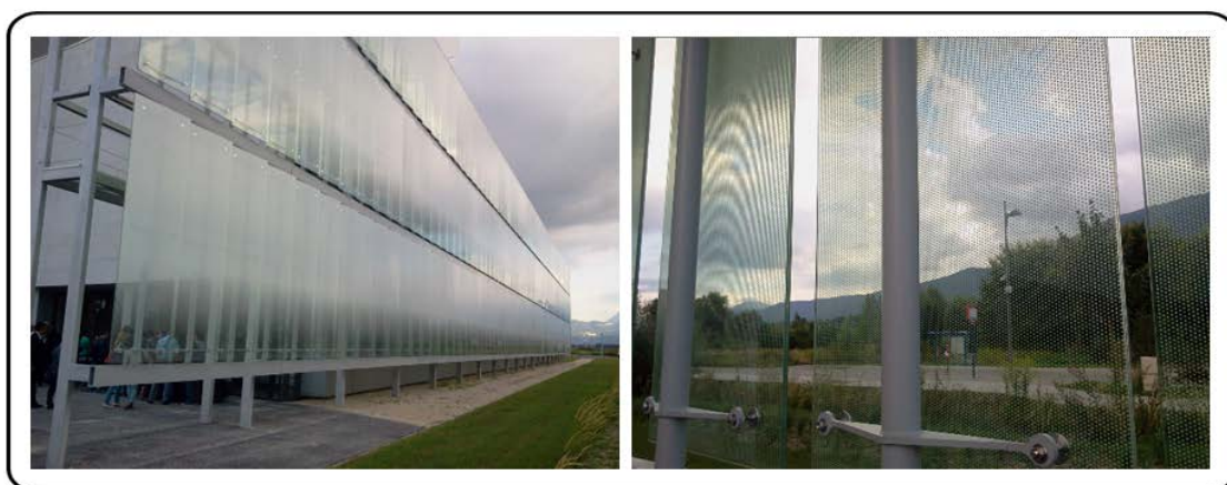
Σχήμα 7.67: Η υιοθέτηση αυτών των συστημάτων επιτρέπει την διατήρηση της οπτικής επαφής με το εξωτερικό περιβάλλον και ταυτόχρονα (ανάλογα με την πυκνότητα του σχεδίου) τη μείωση των ηλιακών κερδών.
