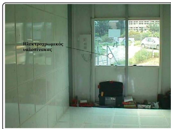
Σχήμα 7.52: Λειτουργία ηλεκτροχρωμικού υαλοπίνακα (Πρόγραμμα Swift, Τμ. Φυσικής, Παν. Αθηνών)
