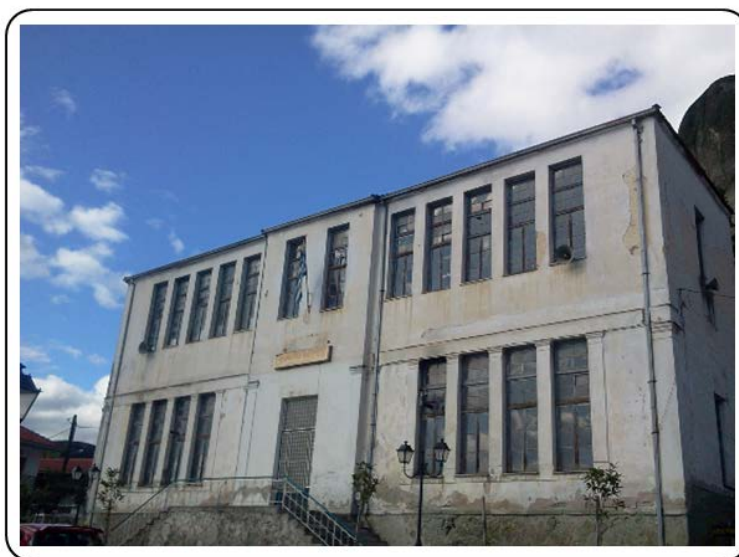
Σχήμα 6.14: Χρήση ανοιγμάτων με αυξημένη κατακόρυφη διάσταση.
