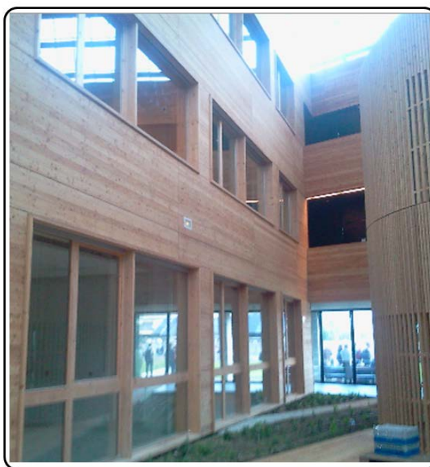
Σχήμα 7.18: Εσωτερικά ανοίγματα σε αίθριο. Παρατηρήστε τη διαφοροποίηση του μεγέθους αυτών καθ' ύψος.
