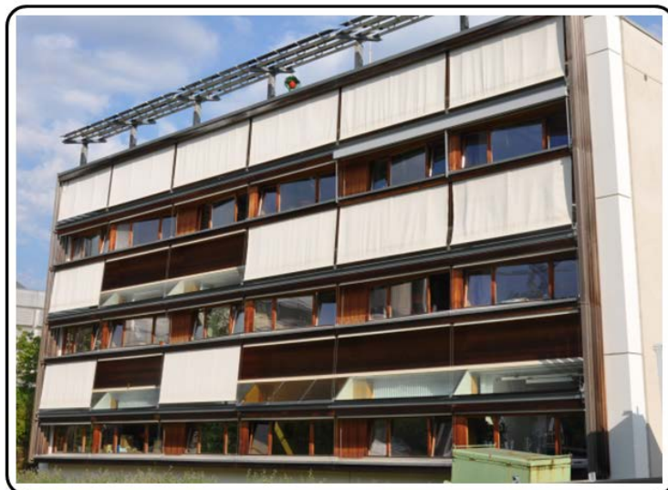
Σχήμα 7.76: Κτήριο με εγκατεστημένο ανειδωλικό σύστημα φυσικού φωτισμού. Φωτ. Α. Δράκου, TAM, ΠΘ.
