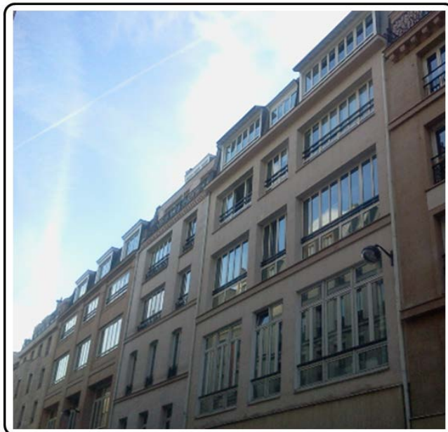
Σχήμα 7.5: Οι διαστάσεις των ανοιγμάτων μειώνονται με την αύξηση της απόστασης τους από το έδαφος (μεγαλύτερη παροχή φυσικού φωτισμού).
