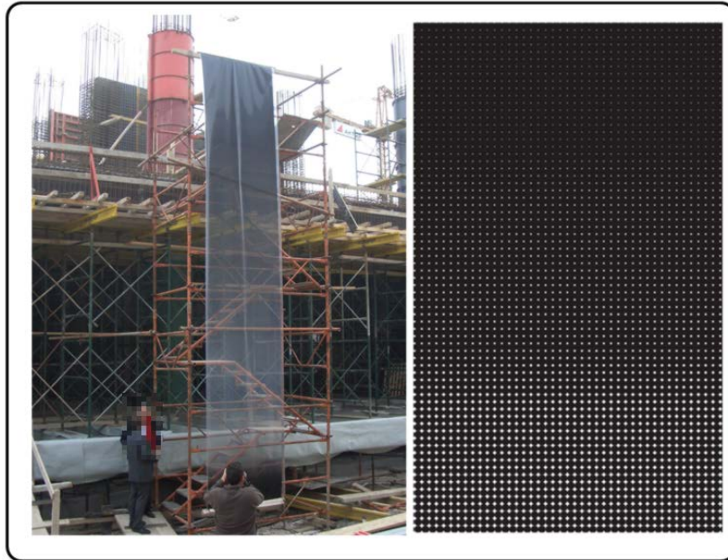
Σχήμα 7.68: Η μέση τιμή του συντελεστή ηλιακών κερδών (της πρόσοψης) μπορεί να μειωθεί σημαντικά με αύξηση της πυκνότητας του σχεδίου εκτύπωσης όσο αυξάνεται η γωνία από τον άξονα όρασης.
