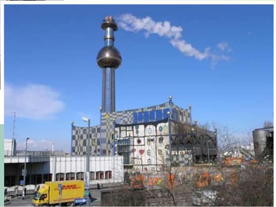
Καμινάδα του Αυστριακού εργοστασίου καύσης (Βιέννη).
