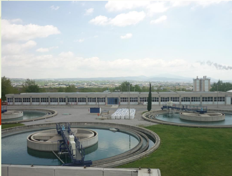
Μονάδα επεξεργασίας νερού φράγματος Θεσσαλονίκης
