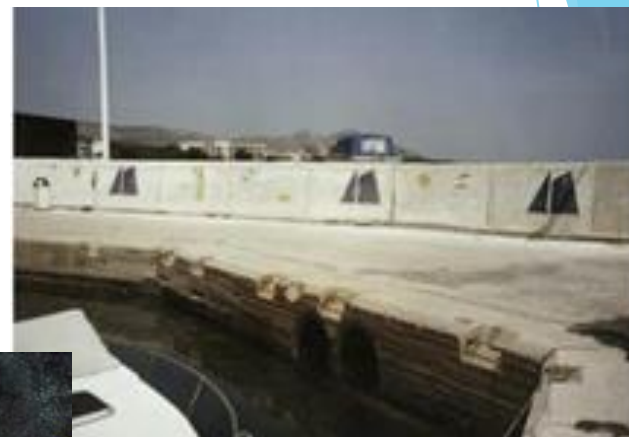
Κυματοθραύστης με αγωγό ανανέωσης στο Μάτι.
