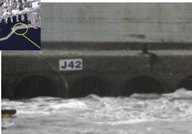
Κυματοθραύστης με αγωγό ανανέωσης στην Καλαμάτα.
