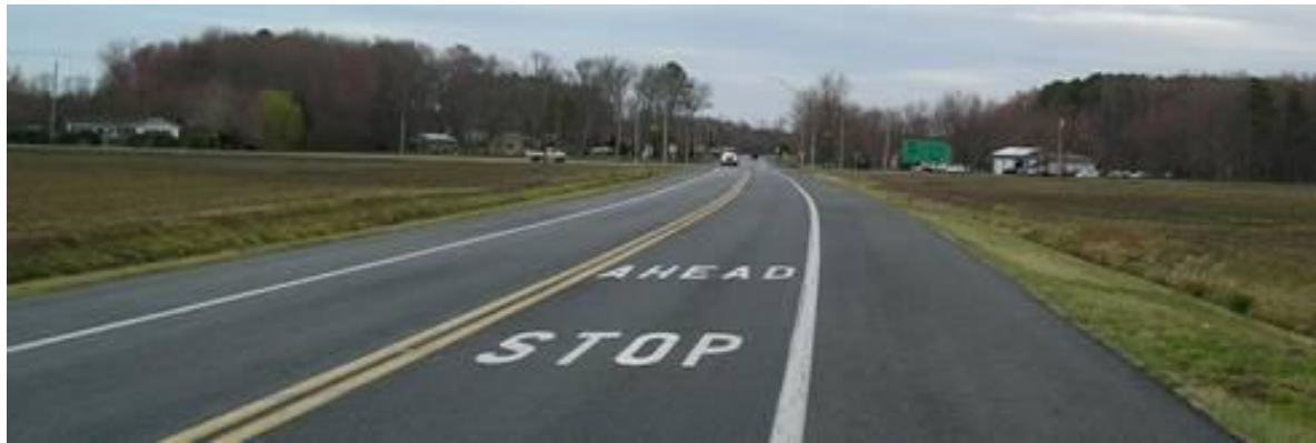
Εικόνα 7.9: Διαγράμμιση οδοστρώματος με “STOP”
