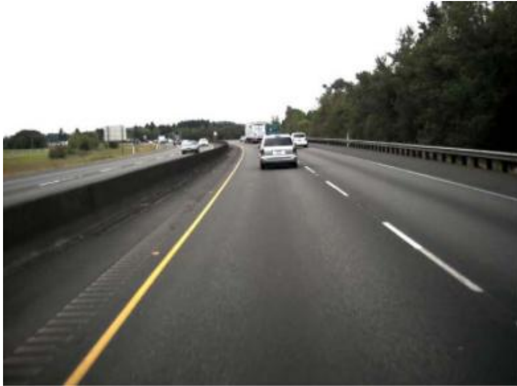
Εικόνα 6.2.10: Εγκατάσταση συνεχών λωρίδων τραχείας επιφάνειας σε ερείσματα
