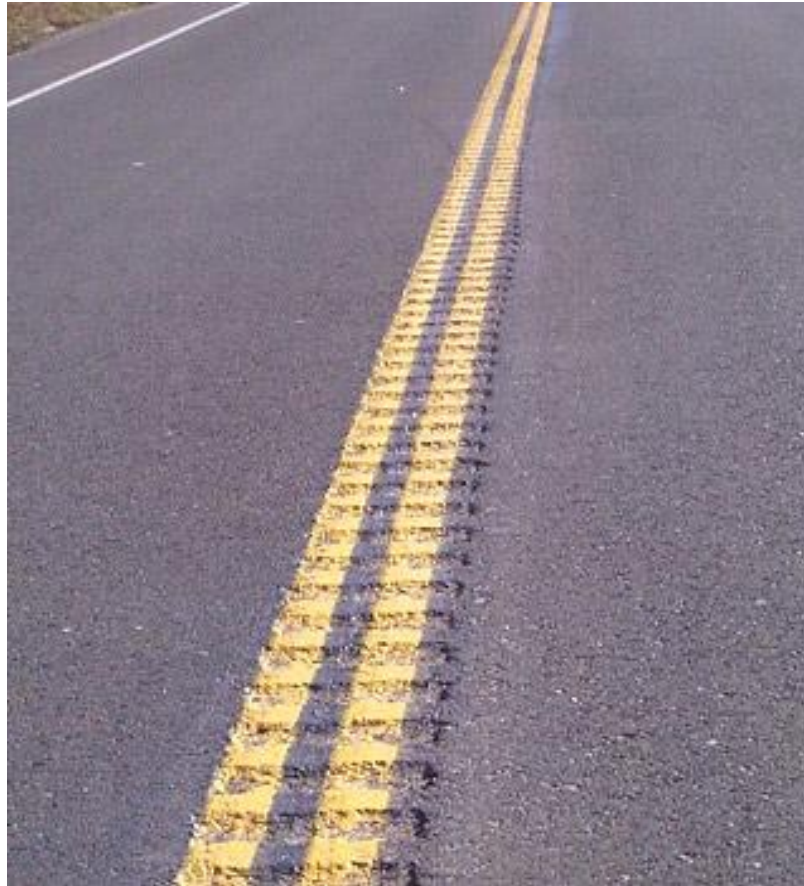
Εικόνα 6.2.12: Εγκατάσταση λωρίδων τραχείας επιφάνειας στη διαχωριστική γραμμή
