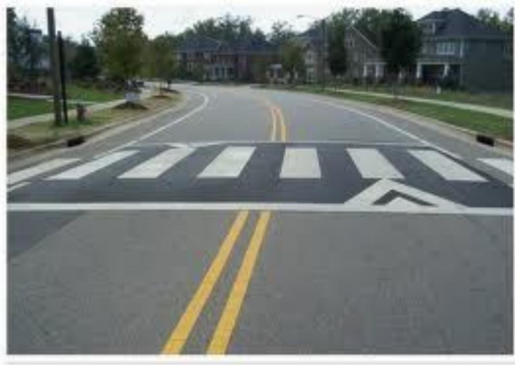
Εικόνα 6.2.13: Εγκατάσταση ρυθμιστών ταχύτητας
