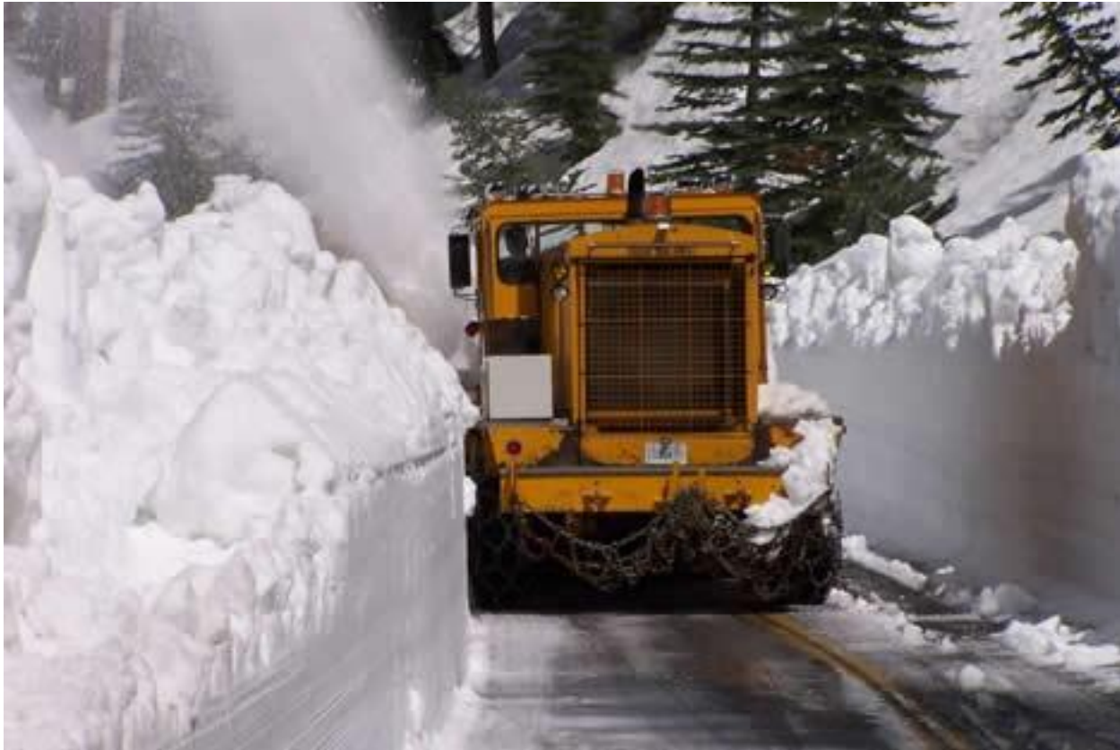
Εικόνα 6.2.20: Απομάκρυνση χιονιού για τη συντήρηση της οδού
