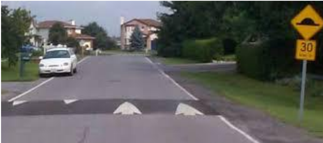
Εικόνα 6.2.15: Εγκατάσταση ρυθμιστών ταχύτητας
