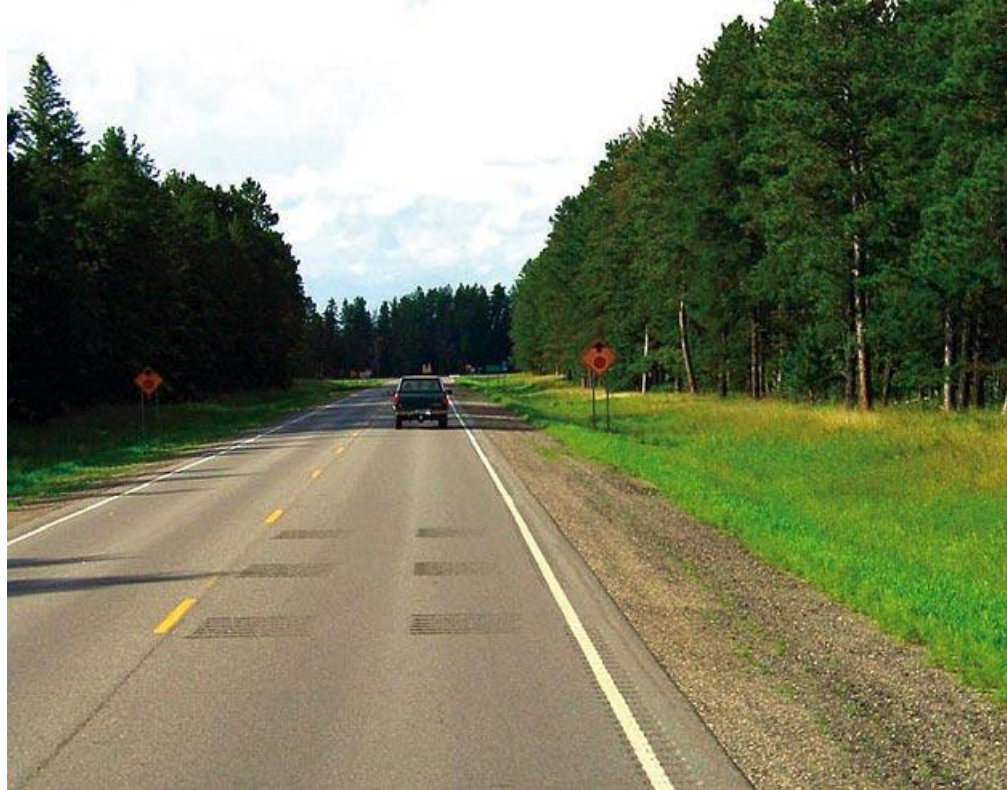
Εικόνα 6.2.14: Εγκατάσταση εγκάρσιων λωρίδων τραχείας επιφάνειας
