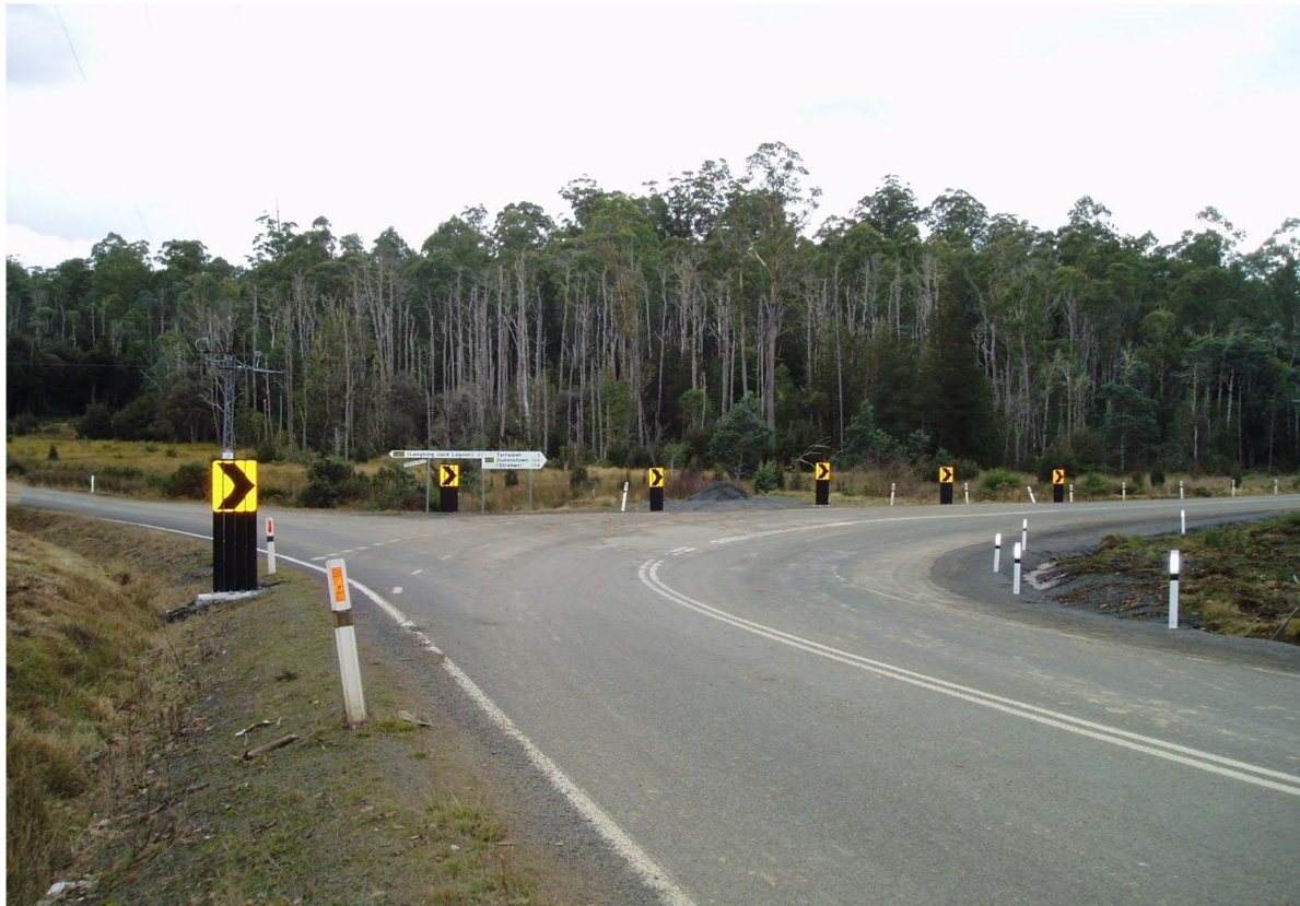
Εικόνα 6.2.7: Εγκατάσταση κατακόρυφης σήμανσης σε οριζόντιες καμπύλες
