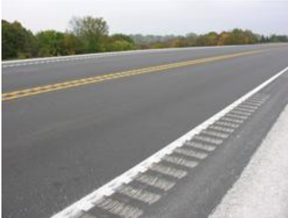
Εικόνα 6.2.8: Εγκατάσταση συνεχών λωρίδων τραχείας επιφάνειας σε ερείσματα
