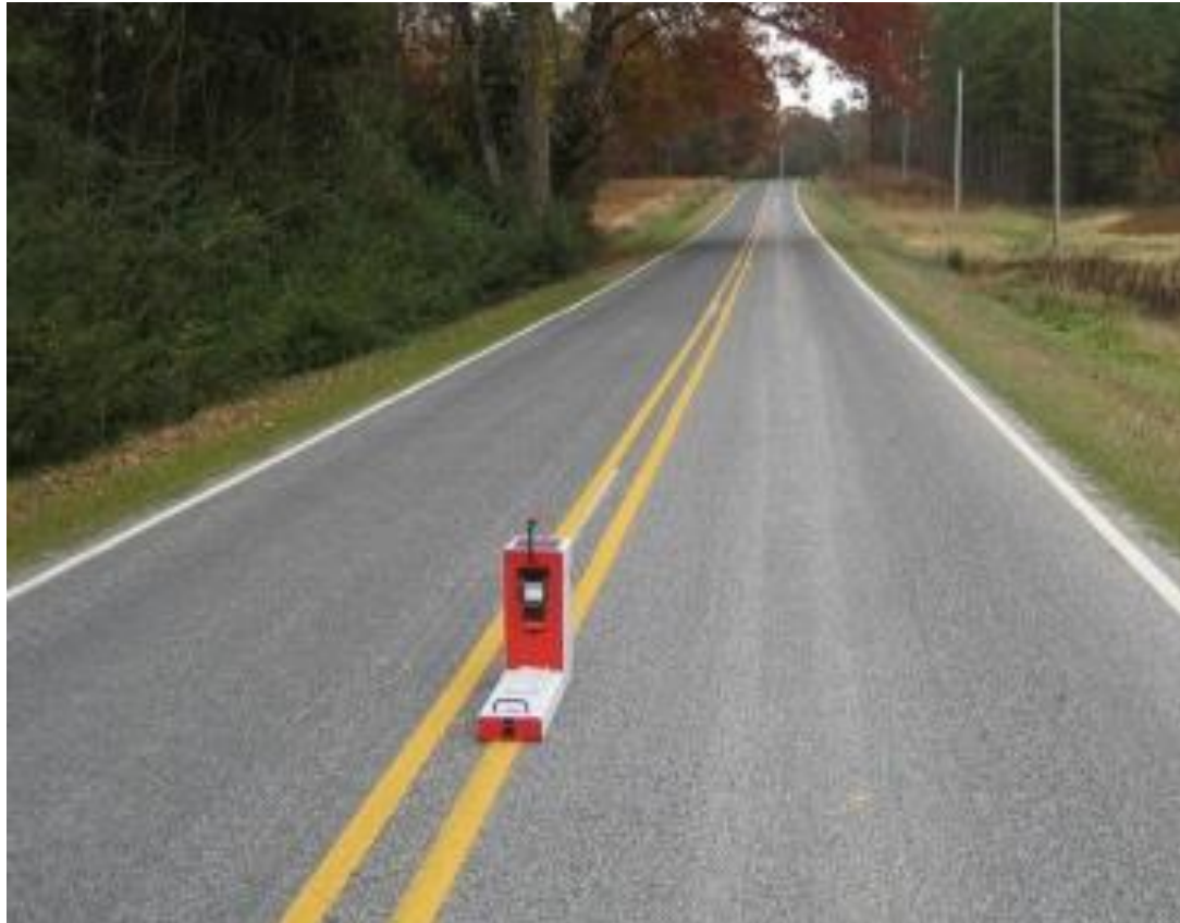
Εικόνα 6.2.5: Εγκατάσταση υπερυψωμένων δεικτών χιονιού – Επαρχιακή οδός
