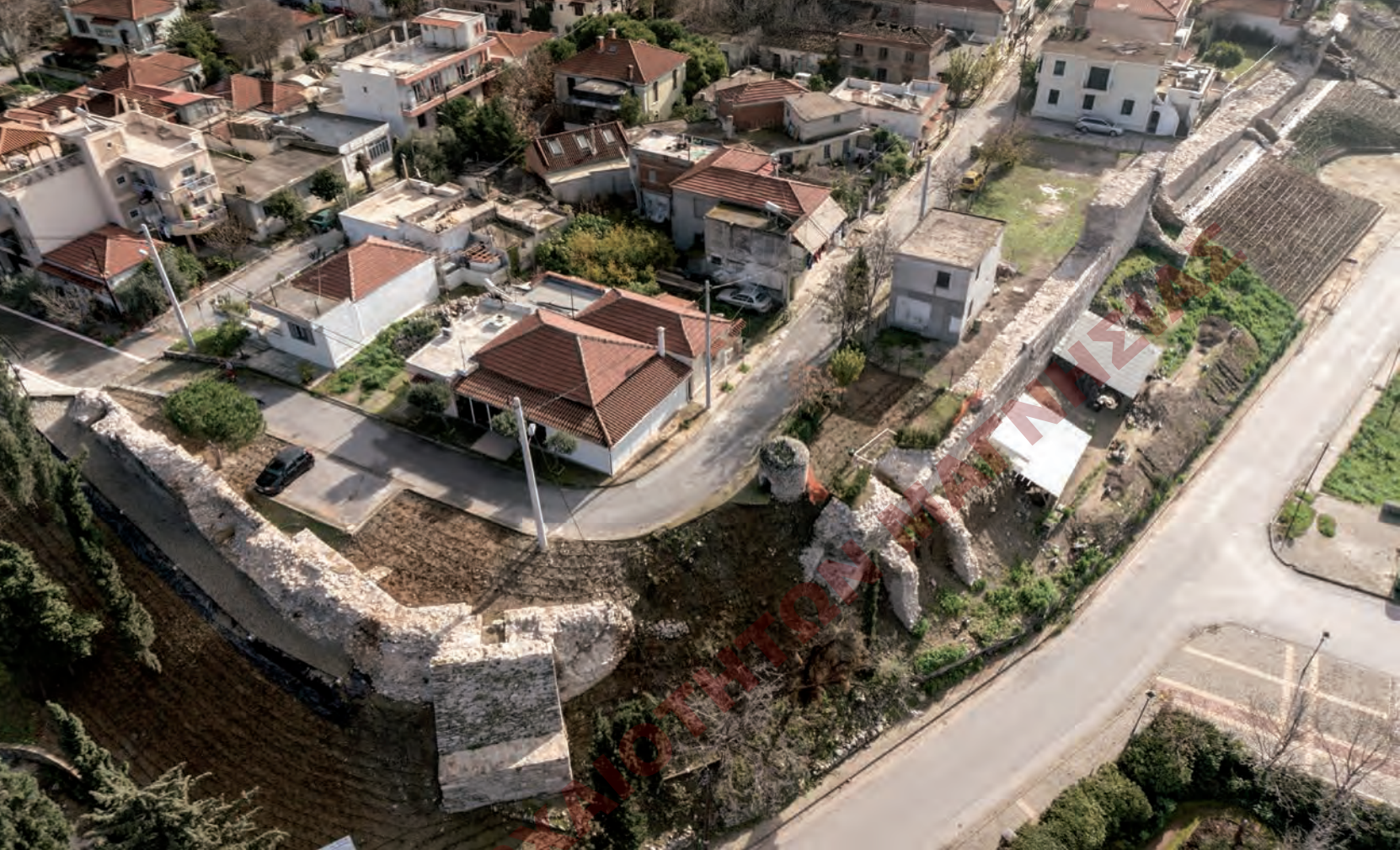
Τμήμα της βόρειας και δυτικής πλευράς της οχύρωσης • Section of the north and west sides of the circuit wall
