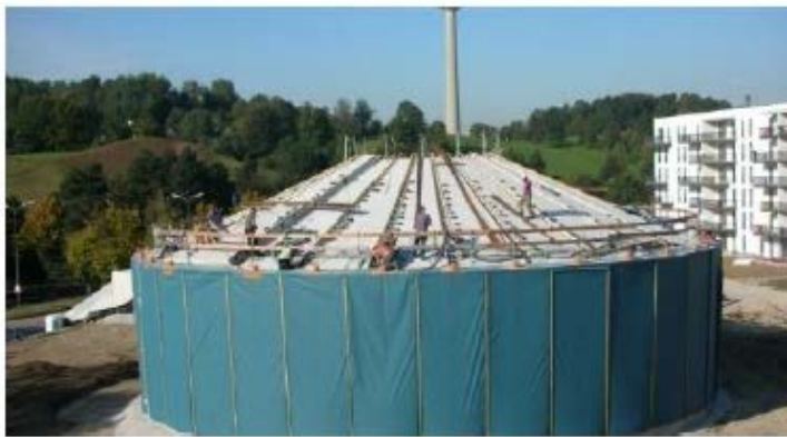
Κατασκευή δεξαμενής εποχιακής αποθήκευσης 5700 m 3 στο Μόναχο Γερμανίας έτος 2007
