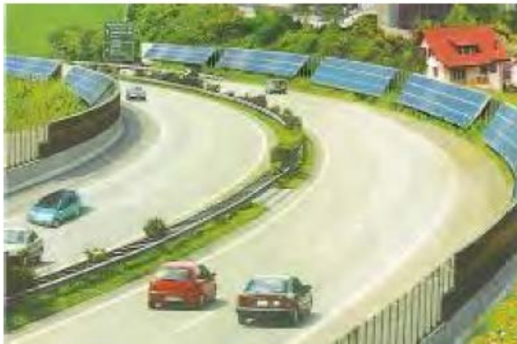
Εφαρμογή φωτοβολταϊκών σε ρόλο ηχοφράγματος σε αυτοκινητοδρόμους
