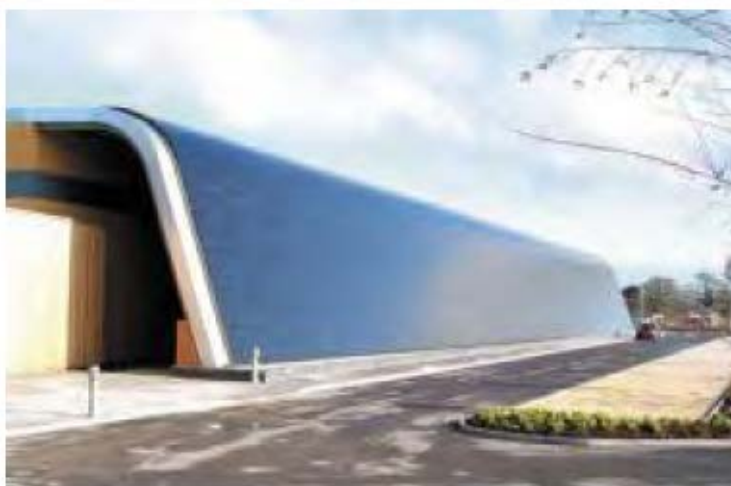
Ενσωμάτωση φωτοβολταϊκών σε δημόσιο κτίριο
