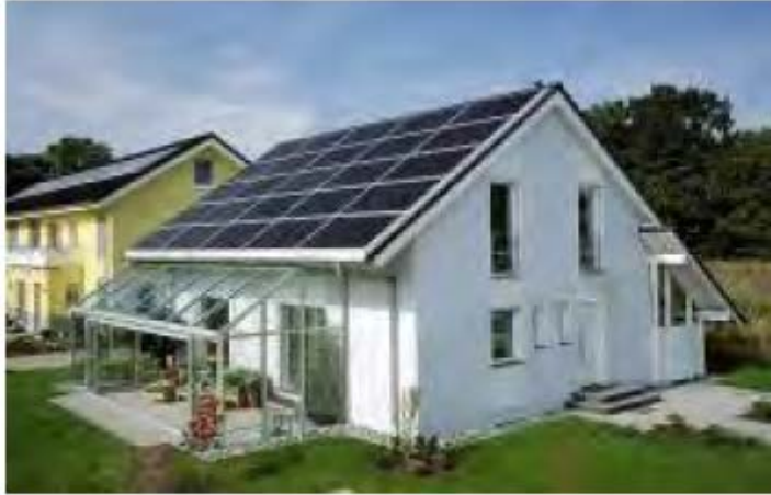
Ενσωμάτωση φωτοβολταϊκών σε στέγες κτιρίων
