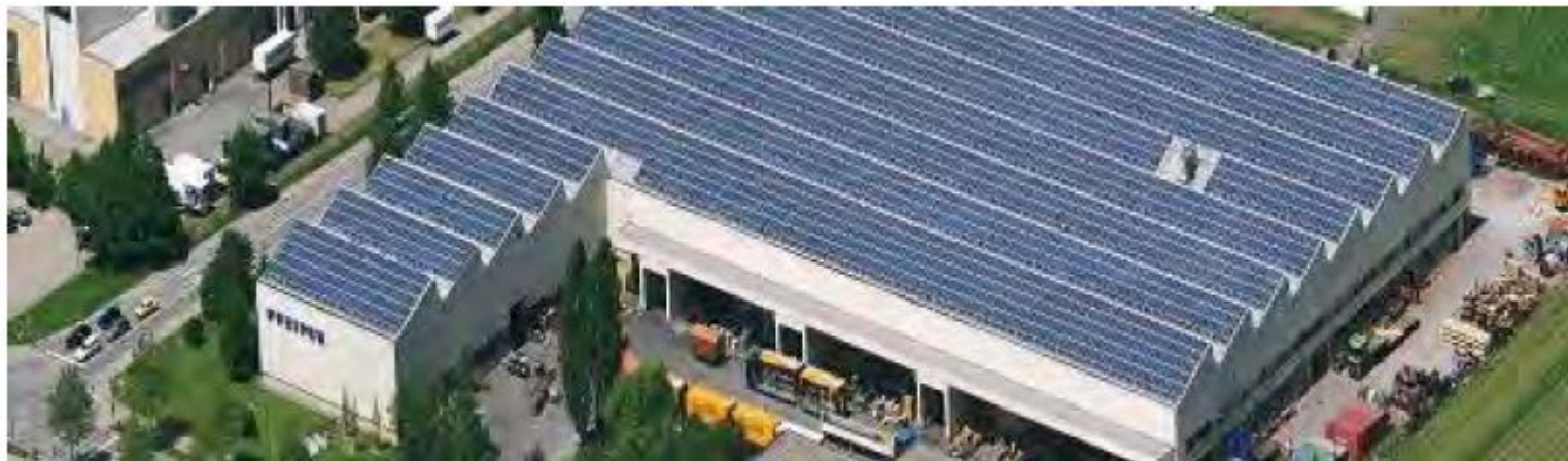
Ενσωμάτωση φωτοβολταϊκών σε βιομηχανική στέγη
