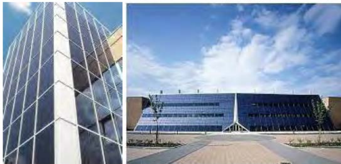
Εφαρμογές φωτοβολταϊκών σε προσόψεις κτιρίων
